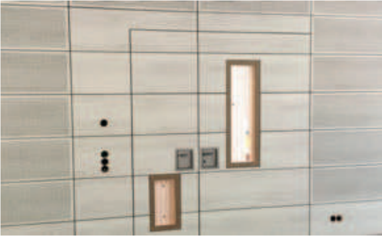
Die neuartige Akustiklochung sorgt für ein angenehmeres Klangverhalten in der Halle. Fotos: Hamberger Flooring GmbH&Co.KG/ HARO
