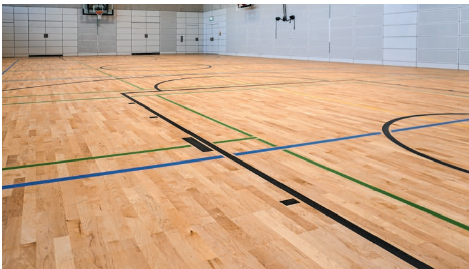
360 Quadratmeter HARO Sportboden wurden in der neuen Halle in Daglfing verlegt.
