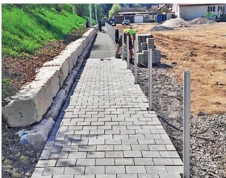
Um den Platz herum wurden etwa 500 Quadratmeter Wege neu gepflastert. Foto: Garten-Moser
